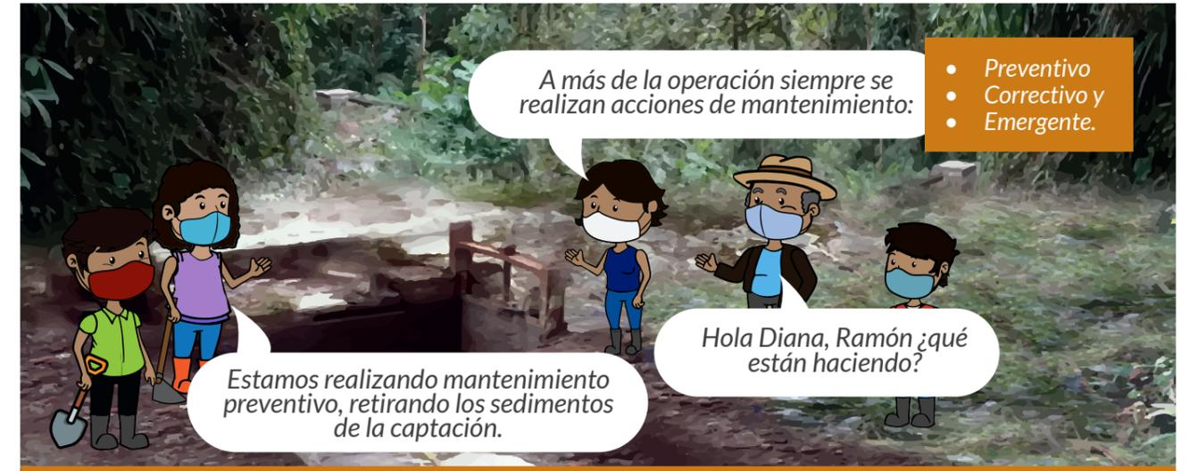
Las labores de limpieza en la captación y desarenador las hacemos siempre al inicio de una nueva jordana de riego y semanalmente según la cantidad de escombros y sedimentos depositados en estas estructuras.
